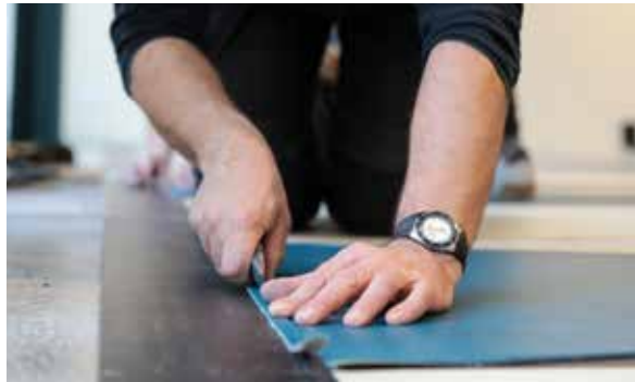
Abb. 6 Das exakte Anpassen erfolgt dann wie bei einem Nahtschnitt mit Anreißer und Unterkantenschnitt.
