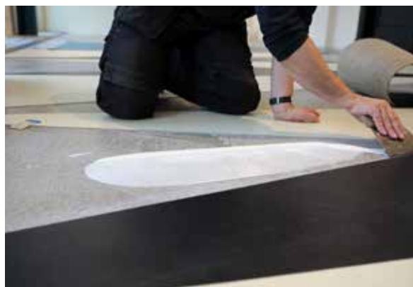
Abb. 4 Beim Verkleben muss man den Klebstoff exakt dosieren und die Einlegezeiten einhalten.
