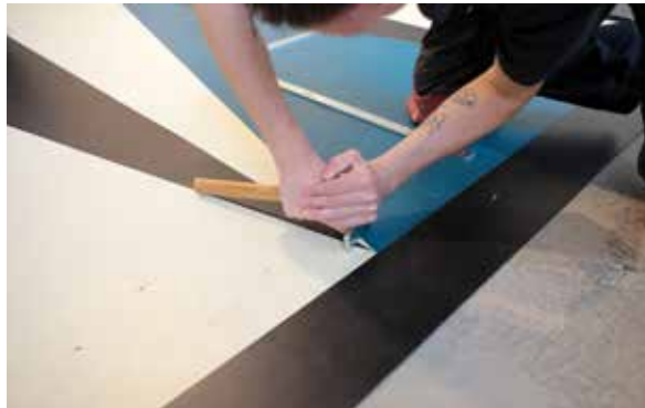
Abb. 8 Zum Schluss werden die Nähte vorsichtig, aber kraftvoll angerieben, und die Fläche wird angewalzt.
