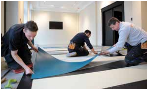
Abb. 5 Nachdem zuerst die passgenau geschnittenen Teile verklebt wurden, werden nun die einzupassenden Teile eingeklebt
