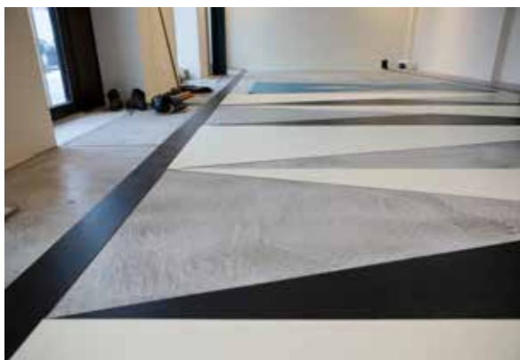
Abb. 3 Nach dem exakten Übertragen der Maße des Verlegeplans kann mit dem Zuschnitt der Teile begonnen werden.
