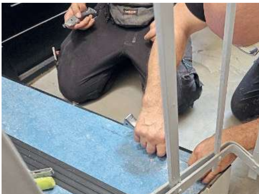
Lino im Treppenhaus: Schwerpunkt der unternehmerischen Tätigkeit von KS Bodenbelagsarbeiten ist Berlin.
